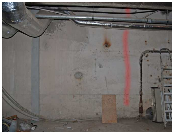
Fot.1 i 2. Pęknięcia wewnętrznych ścian żelbetowych
