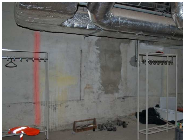
Fot.1 i 2. Pęknięcia wewnętrznych ścian żelbetowych
