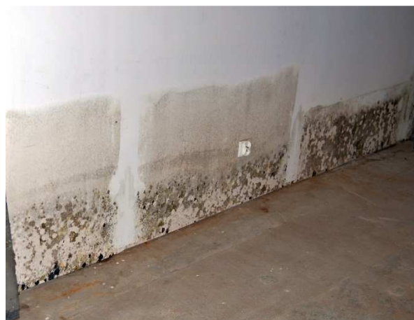
Fot. 4. Pleśń na zawilgoconych ścianach
