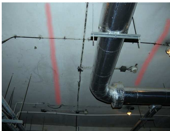
Fot. 3. Rysy na stropie nad piwnicą
